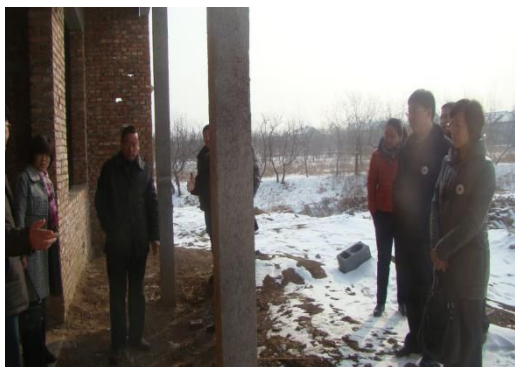
居民活动室建设现场
